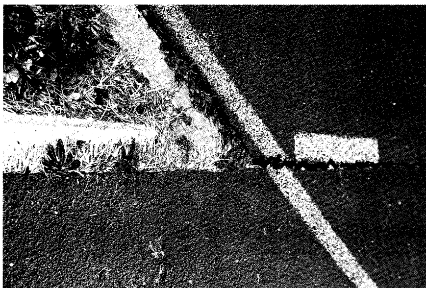
Foto 4 - Carenza di manutenzione nel cordolo perimetrale della pista
